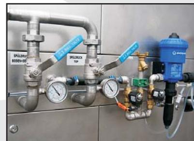
Spritzdruckregulierung des oberen und unteren Düsenstranges, sowie automatische Reinigerdosierung
